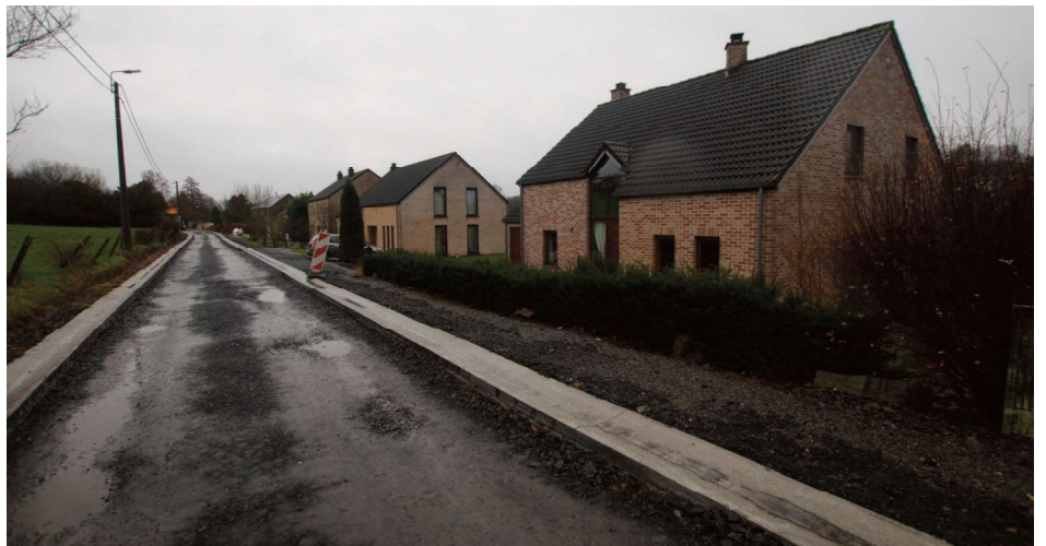
Fig. 9. Construction de nombreuses nouvelles maisons et réfection de la voirie rue Fond de Vaux pour répondre à l'extension urbanistique que connaît la zone de Lesve.
