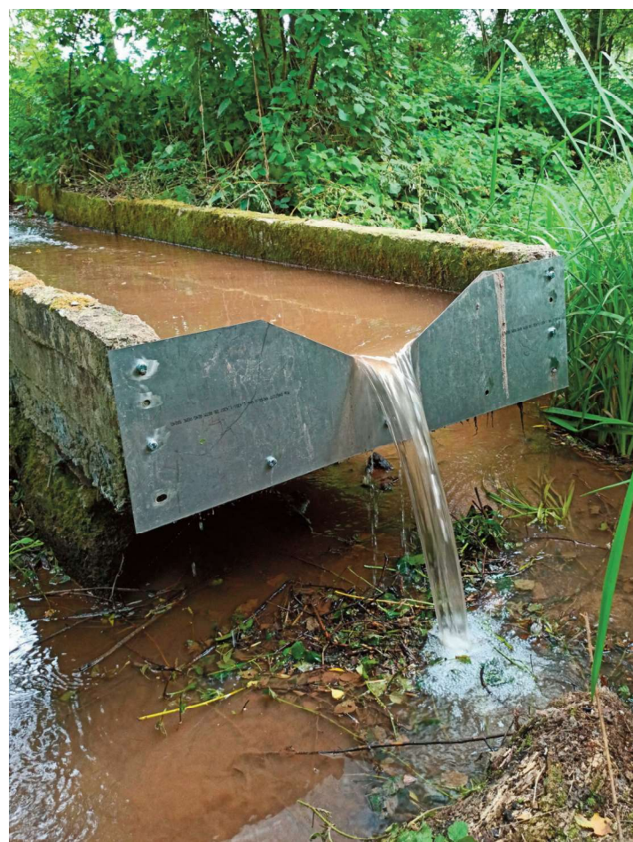
Fig. 4. Ce bief en béton (équipé d'un déversoir pour mesurer le débit) amène les eaux des étangs directement dans la grande doline du Trou du Moulin (point B), évitant que les eaux ne s'infiltrent au contact des calcaires givetien.
