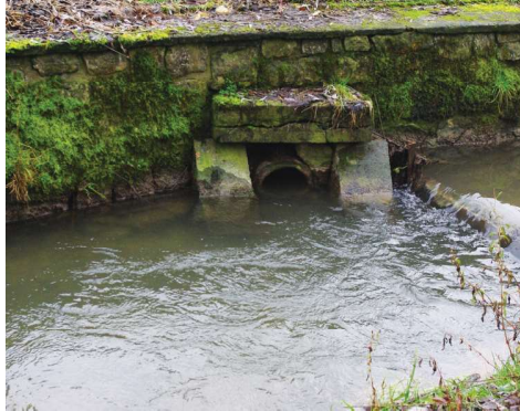
Fig 07. Deux arrivées directes d'eaux usées dans le village de Falmignoul en amont des pertes
