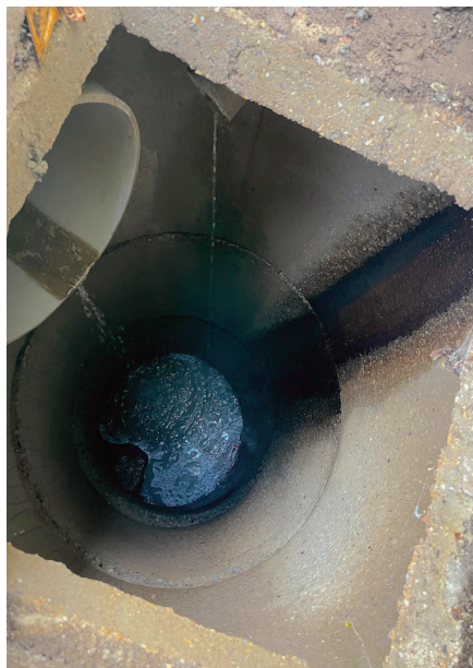
Photo 2 : Le pertuis artificiel aménagé au droit de la perte de La Grange où se déverse une partie des eaux drainées sous les rues du village et qui s'infiltrent dans la roche sous-jacente
