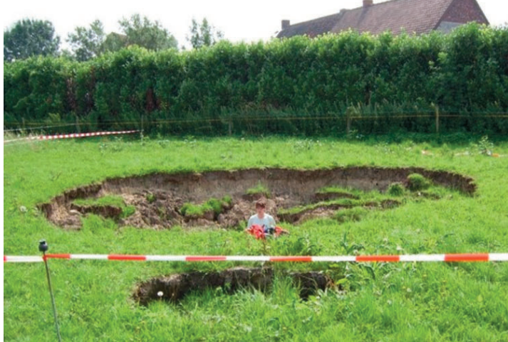
Fig. 4. Exemple d'effondrement sur les deux territoires. A gauche : effondrement en zone karstique, dans le Tournaisis (© SGW). A droite : effondrement au droit d'une carrière souterraine de craie en zone urbaine (© Ville de Lille).
