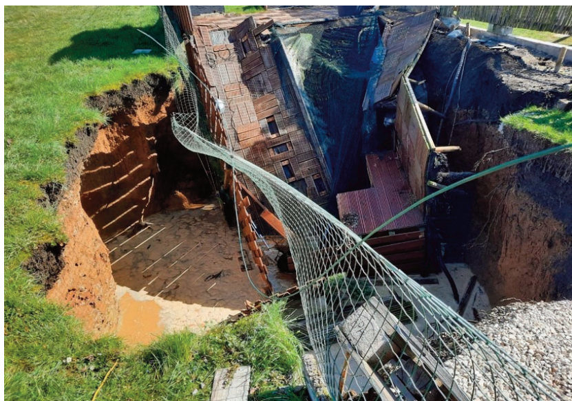
Fig. 8. Effondrement dans un jardin privé (photo et dossier CACEff).
