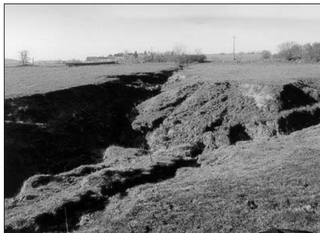
Dans la prairie en aval du trou Balza, une érosion très marquée se note dans le vallon formé à partir de la Fontaine St Martin. Cette érosion met en avant l'épaisseur des terrains de couverture (plusieurs m), excepté au trou Balza où le calcaire affleure
