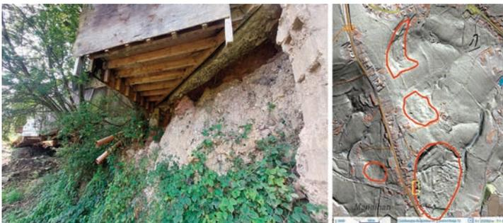
Fig.7. Manaihan – 7a : Atelier en porte à faux en amont du glissement (F Polrot) – 7b : Cernées de rouge, les zones de contraintes fortes de glissements dans lesquelles l'image Lidar montre souvent des reliefs mouvementés ; en jaune, le bâtiment de la photo (WalOnMap mod FP2024).
