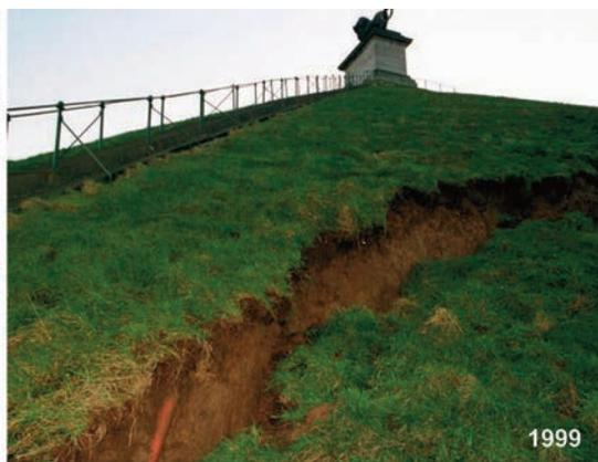
Fig. 12a. & b. . La butte de la bataille de Waterloo - Glissement de terrain en 1995 (WalOnMap) ; fissure de décrochement du glissement de 1999 (SPW).
