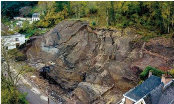
Fig.10. - Namur – vue du glissement de terrain rue Saint Martin, submergeant le chantier ouvert à la base de la colline. (Photo, V. Lorent)
