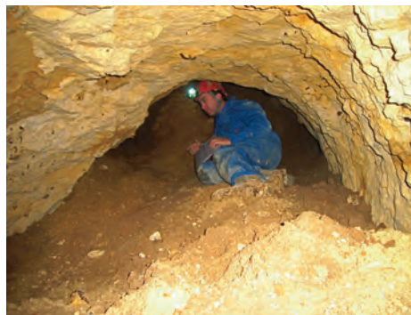
Fig 7. L'effondrement vu de l'intérieur lors des investigations de stabilité (photo SPW).
