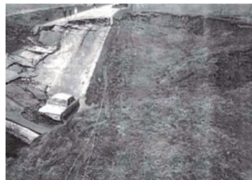
Fig. 17. Rhisnes. À gauche: en rouge, la zone effondrée en 1967 (SPW). À droite: vue en surface de l'effondrement ayant emporté la route sur plus de 30m de long.
