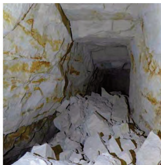
Fig. 11. À gauche, aperçu de l'affaissement en surface, s'étendant sur plus d'un Ha (photo Police fédérale, 2015). À droite: malgré son allure, cette remontée de fontis linéaire n'est pas une galerie mais bien le vide d'effondrement au-dessus de la galerie (« migration » verticale du vide initial). Le sommet des éboulis se trouve à 4 m au-dessus du sol de la galerie, au niveau de son toit (fontis linéaire sur faille, Cuesmes, photo SPW, SGW).
