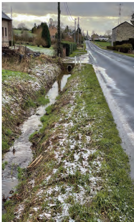
Photo 2. Le fossé qui longe la RN 807 draine les eaux issues du versant Sud qui le surplombe à gauche. En haut à droite de la photo, la maison derrière laquelle se situe la chantoire de Soy. On y devine aussi le creux du fond du vallon.
