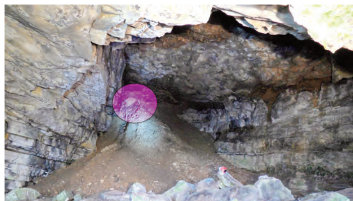
Fig. 15. Carrière Arquet haut: Coupe simplifiée de la salle 1 avec effondrement (/bas: vue de l'effondrement en fond de salle (rond mauve).
