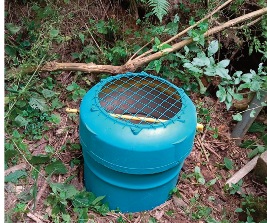
Fig05. En juillet 2025 le puits d'accès à la Grotte Michel est sécurisé à l'aide d'une buse.
