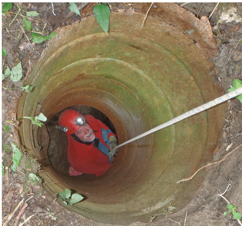
Fig. 1. Accès via un "tube" à la grotte Michel située à l'aval du chantoir. Cet aménagement permet d'atteindre la roche en place au travers des éboulis (photo JP Liégeois)
