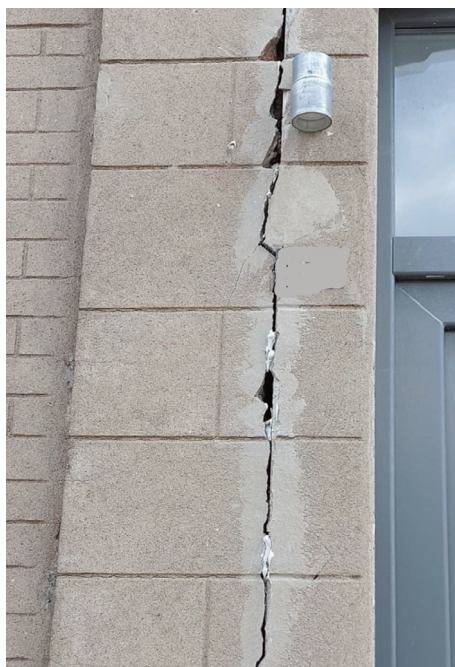
Fig. 02 A quelques m de l'effondrement la paroi de la maison laissant voir une « belle » fissure sur près de 2m de haut (photo JPL).
