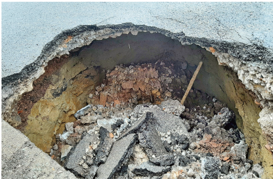
Fig. 01. Effondrement de la rue de la Glacière, laissant voir sous le tarmac et un niveau de « briques concassées » un sable jaune bien stratifié qui a subi un important soutirage provoquant la rupture de la route (processus de fontis – photo 27/06/2025 - DC
