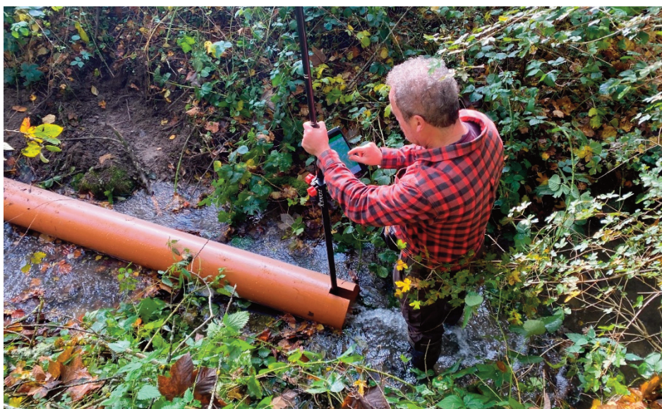
Fig. 12. Pose d'un tube PVC dans le lit du ruisseau au point D pour disposer d'une section régulière et pouvoir y effectuer une mesure de débit correcte.
