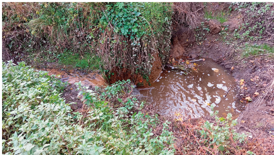
Fig. 5. En période très sèche (début octobre 2025), le ruisseau d'Agrismont se limite à un écoulement de quelques l/s. Il se perd entièrement dans un affaissement d'1 m de profondeur dès son entrée sur les calcaires. Cette perte sature rapidement en cas de pluie pour voir la rivière se poursuivre jusqu'au chantoir d'Agrismont.
