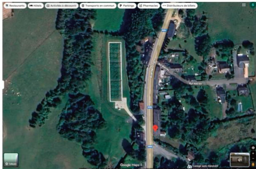
Fig. 2. Vue aérienne de la STEP en 2025 (Google). On distingue l'importante emprise au sol des trois cuves étagées recouvertes de roseaux qui reçoivent les eaux usées.
