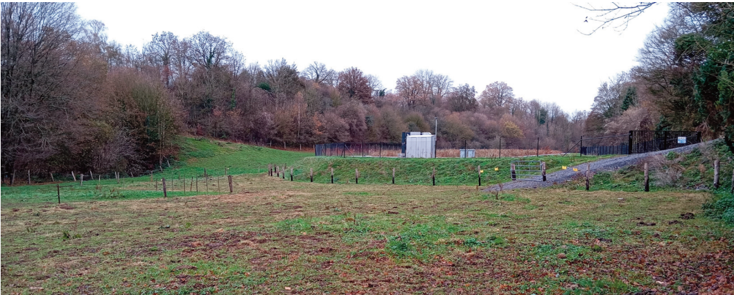
Fig. 5. La nouvelle STEP vue depuis l'amont. Le chantoir se trouve dans le bosquet à gauche, l'usine d'épuration est sur un terre-plein surélevé, afin de limiter les risques d'inondation en cas de crue.
